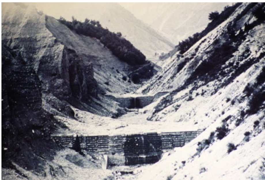
Figure 1: Restoring watersheds in the Italian Alps with check dams, ca. 1890. G. di Tella, Il Bosco Contro il Torrente (Touring Club Italiano, 1912).
